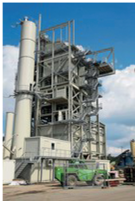
Das Mischwerk im Soltauer Ortsteil Hambostel wird neu gebaut. Foto: wu
